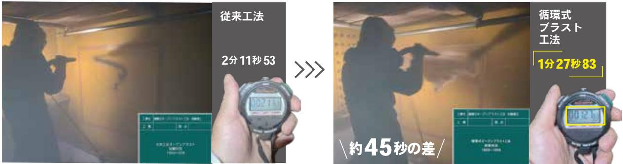
上記の試験結果により、従来のブラスト工法で使用されている 0.7MPa での施工スピードと、循環式オープンブラスト工法で使用される 1.0MPa での施工スピードを比較試験を実施して、循環式オープンブラスト工法の施工効率が従来のブラスト工法に比べ大幅にアップし、工期の短縮が期待できます。
